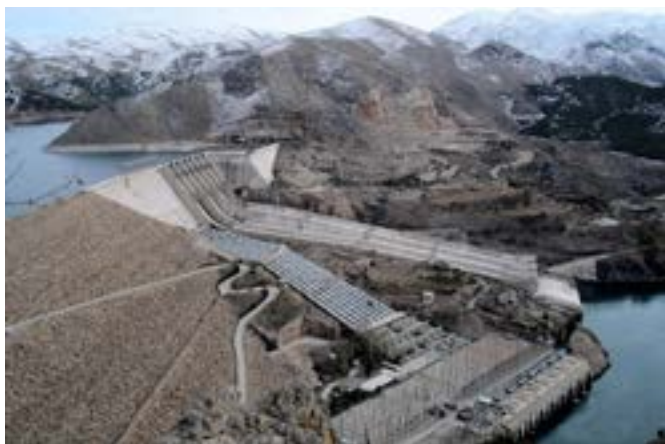
Elektrownia wodna Keban Dam na Eufracie – tureckie hydroelektrownie pokrywają 25% krajowego zapotrzebowania na energię elektryczną (Wikipedia)
